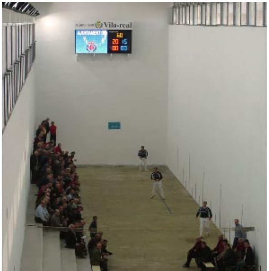
Instalación conjunta de marcador y pantalla en el trinquete de Vila-real. El conjunto está montado sobre la pared del trinquete a más de 7 metros de altura. Las dimensiones aproximadas son 4 metros de largo por 2 metros de alto.
